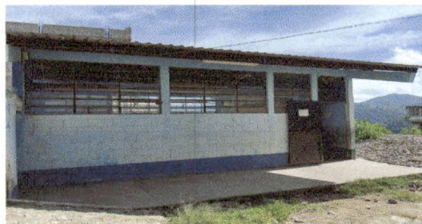
Foto 4: Fotografía módulo 3 sustitución de pintura interior y exterior
