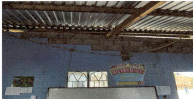
Foto 7: Sustitución de cableado eléctrico en todos los módulos.
