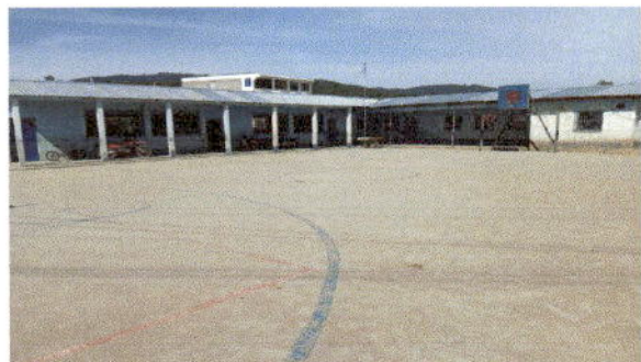
Foto 1: Fotografía módulo 1 sustitución de pintura interior exterior.
