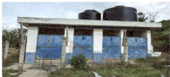
Foto 9: Fotografía módulo 2 sustitución de puertas de baños.
