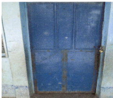
Foto 11: Fotografía del módulo 1 sustitución de puerta.
