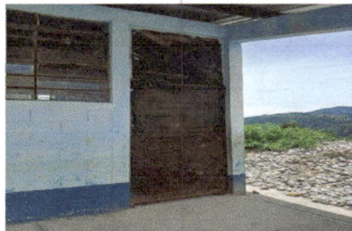
Foto 10: Fotografía módulo 2 sustitución de puerta.
