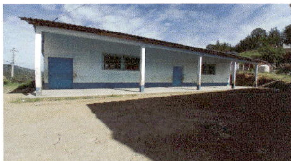
Foto 3: Fotografía del módulo 2 sustitución de pintura interior y exterior.
