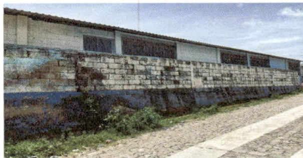
Foto 2: Fotografía muro perimetral sustitución de pintura interior y exterior.
